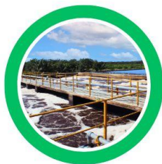
Tratamiento de aguas residuales
